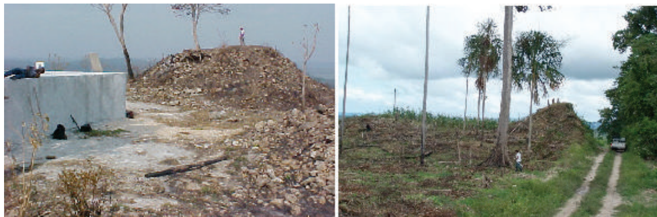
FIGURA 41. CONSTRUCCIÓN DE UNA CISTERNA EN EL SITIO DE LA GLORIA Y DESTRUCCIÓN DE MONTÍCULO EN HUACUTAL
